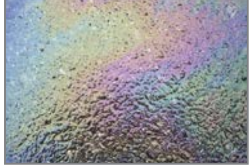
चित्र 5.13: सड़क सतह पर निर्मित थिन ऑयल फिल्म
